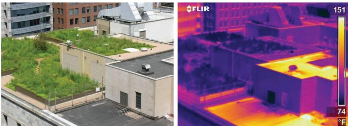
Figura 1 - Diferenças de temperatura entre um telhado verde e convencional. Fonte: WONG et al. (2016).
