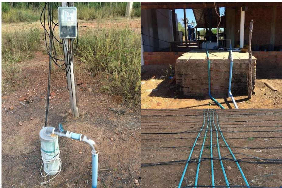
O método de irrigação utilizado em campo foi do tipo localizado por gotejamento. Nas linhas laterais de distribuição, foram utilizadas tubulações de polietileno de 16 mm de diâmetro onde foram instalados gotejadores autocompensantes com vazão nominal de  $2,0 \text{ L h}^{-1}$  para pressões nominais variando na faixa de 5 a 40 mca, espaçados a cada 0,25 m de modo a perfazer a faixa molhada durante seu funcionamento (Figura 6).
