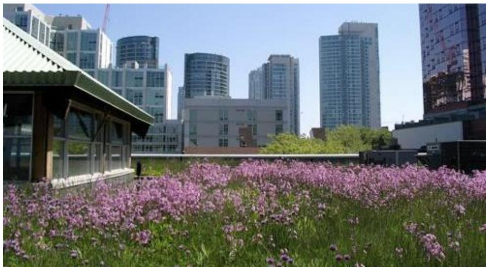
Figura 2: Telhado verde semi-intensivo. Fonte: Ecotelhado, 2017.
