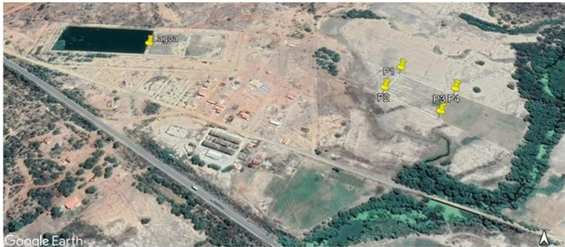
Figura 12 - Localização da área experimental nas proximidades da BR 316 e margens do Rio Brígida. Vista da Estação de Tratamento de Esgoto operada pela COMPESA, no município de Parnamirim-PE.
