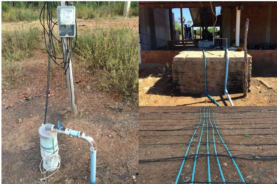
O método de irrigação utilizado em campo foi o localizado por gotejamento. Nas linhas laterais de distribuição, foram utilizadas tubulações de polietileno de 16 mm de diâmetro onde foram instalados gotejadores autocompensantes com vazão nominal de  $2,0 \text{ L h}^{-1}$  para pressões nominais variando na faixa de 5 a 40 mca, espaçados a cada 0,25 m de modo a perfazer a faixa molhada durante seu funcionamento (Figura 6).
